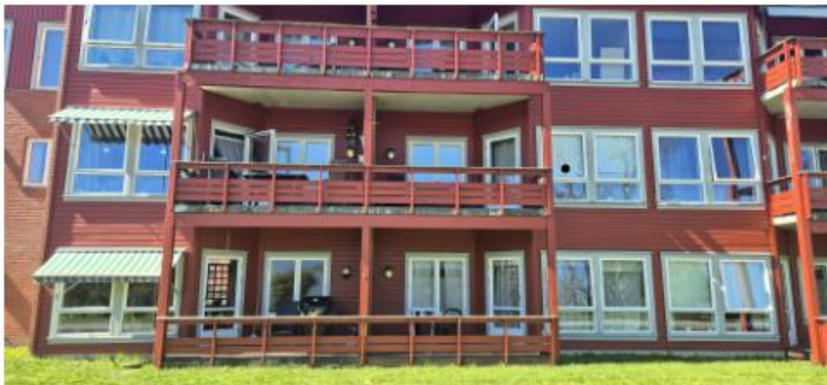
Balkonger med rekkverk over tre etasjer. Rekkverk skiftes ut i sin helhet. Bærende konstruksjon på balkonger skal ikke berøres. Bildet er fra Dr. Sørdringsvei 10. Det er tilsvarende løsninger i Dr. Sørdringsvei 8.
