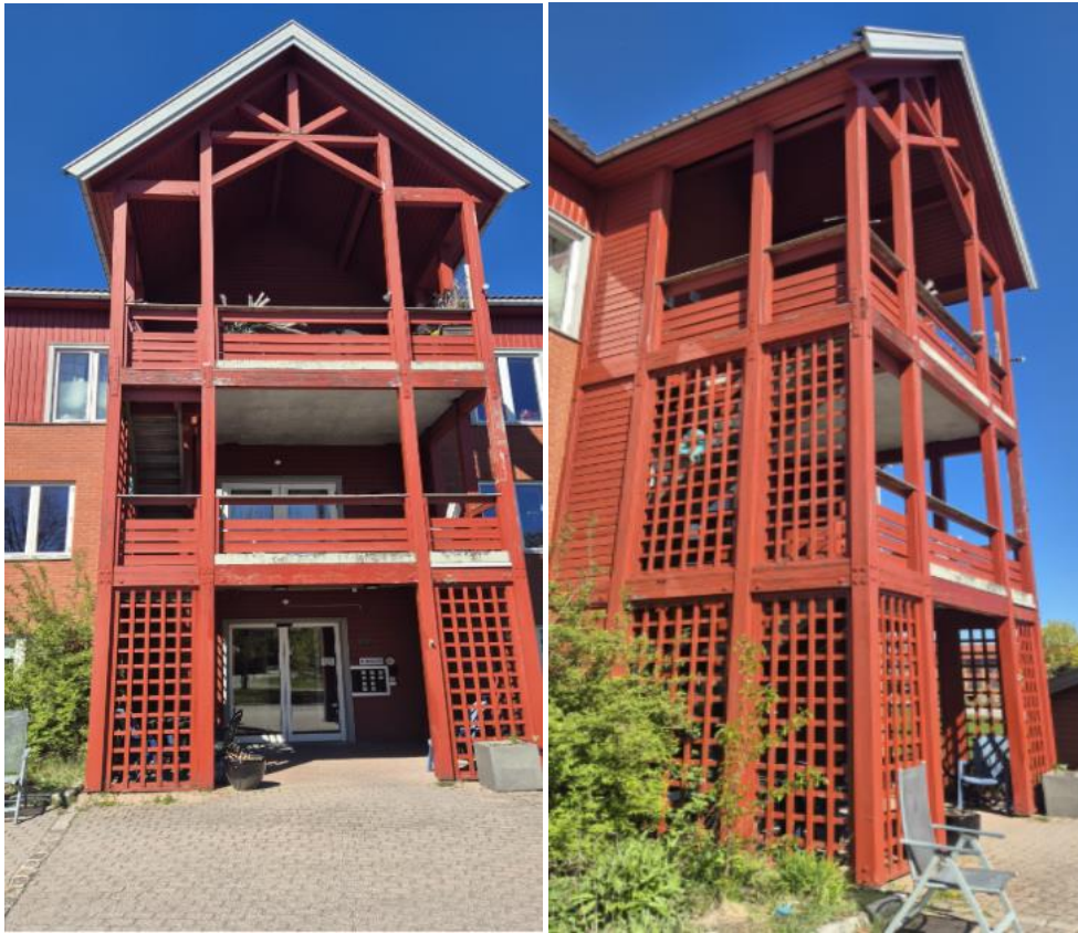
Hovedinngang i Dr. Sørdringsvei 10 med synlig bærende konstruksjon av tre og betong. Det skal prises flere løsninger.
